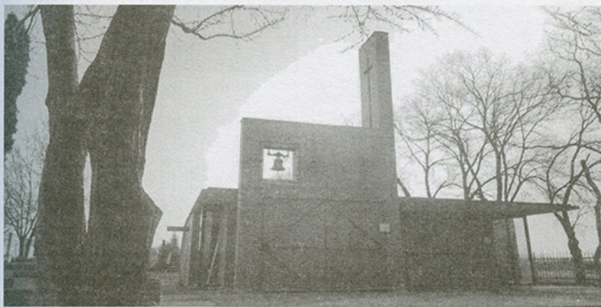
Foto 17.2. Capela nouă din cimitirul orașului.
